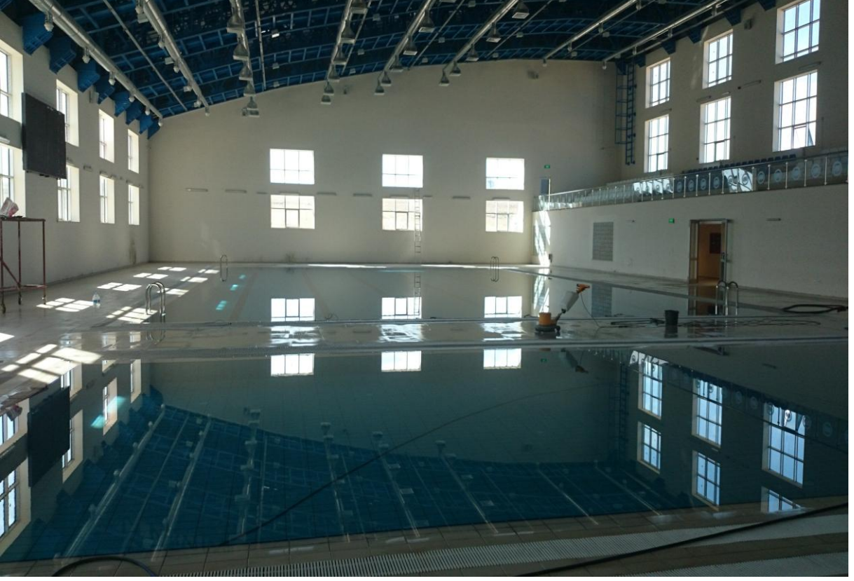
Güneş Enerjili Yarı Olimpik Kapalı Yüzme Havuzu Binası İnşaatı
