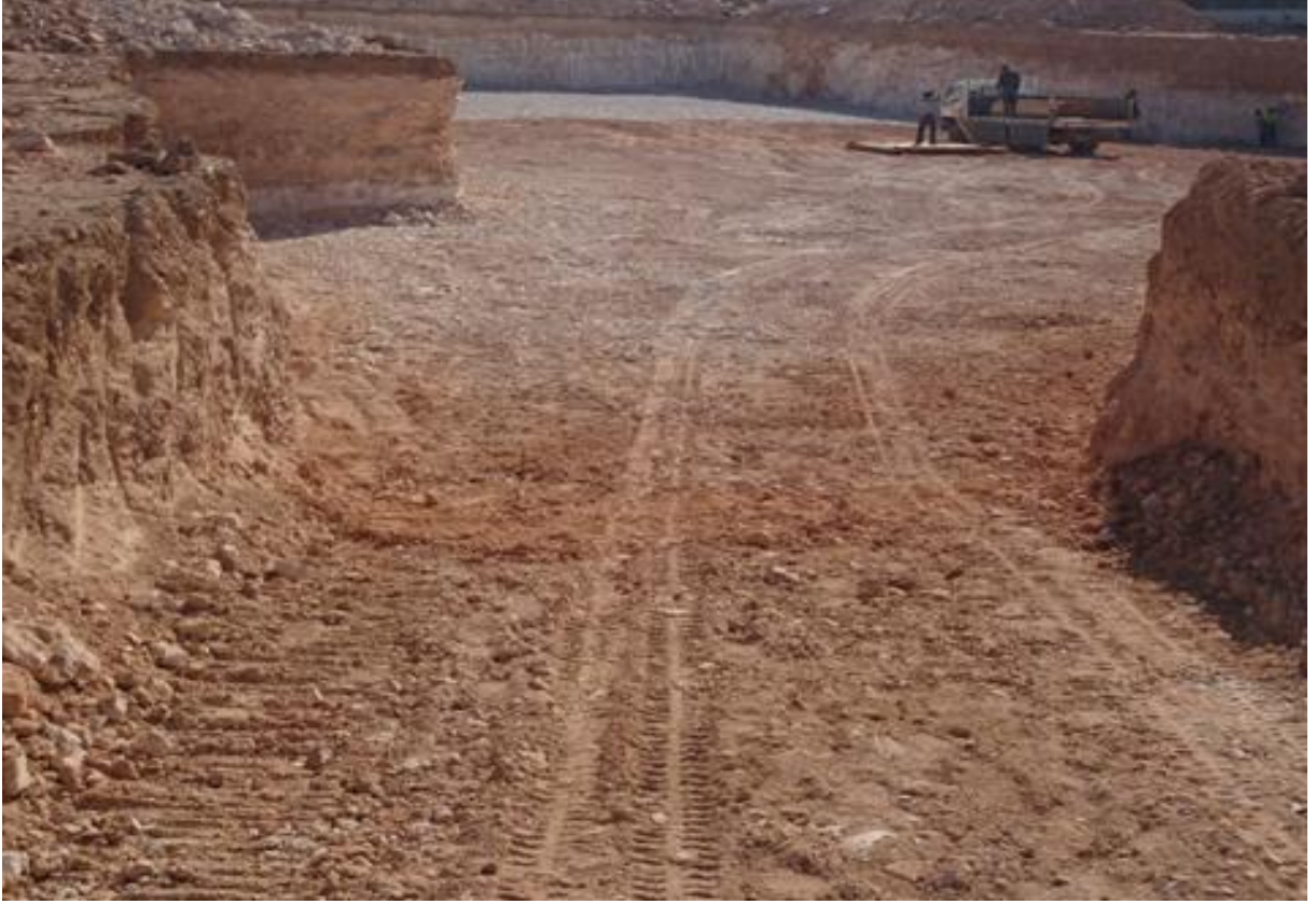
Kütüphane Binası İnşaatı
